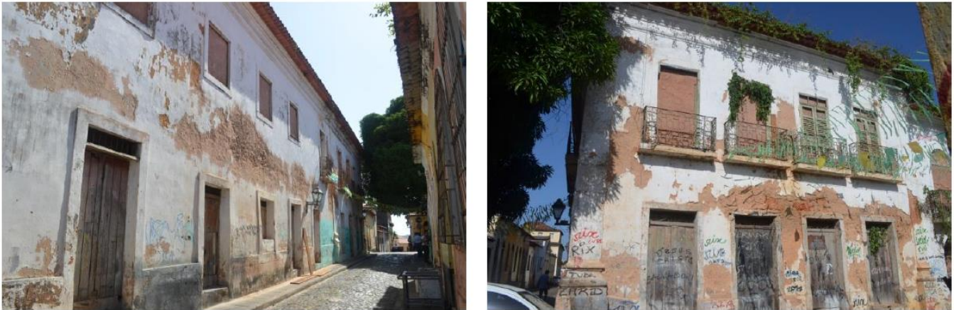
Figura 4 – Situação dos edifícios objeto de restauração na Rua Palma.
