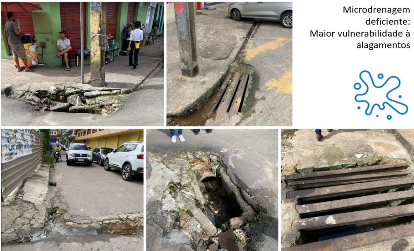
Figura 19 – Elementos da microdrenagem - situação da microdrenagem.
